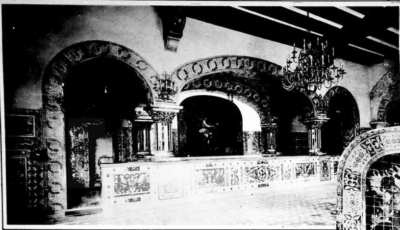
Vista de la cantina, bellissimo trabajo en mosaico.
